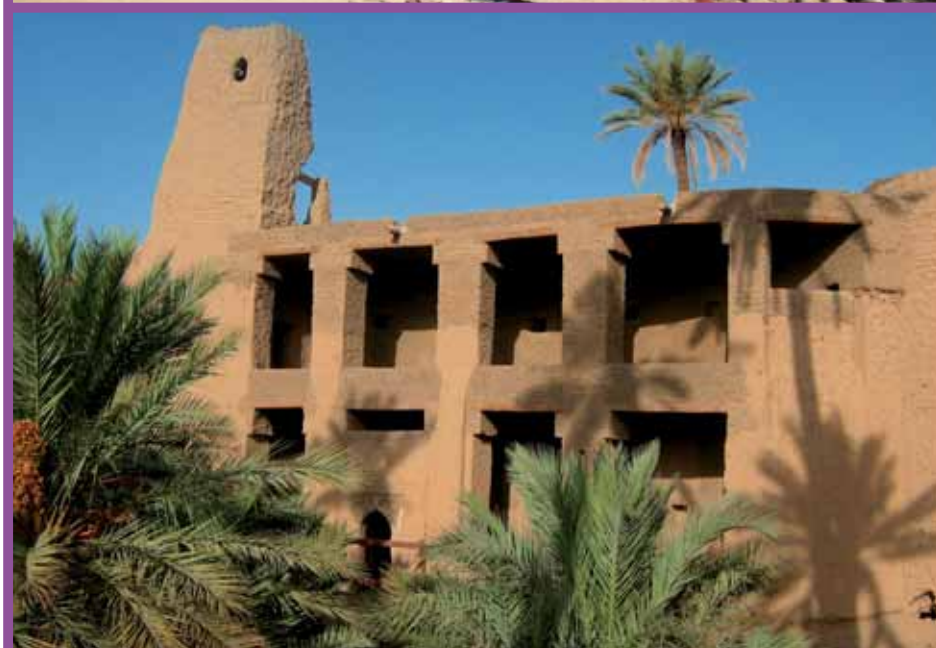
Restauration de la galerie bâtie en terre, place d'Ajdir à Figuig
