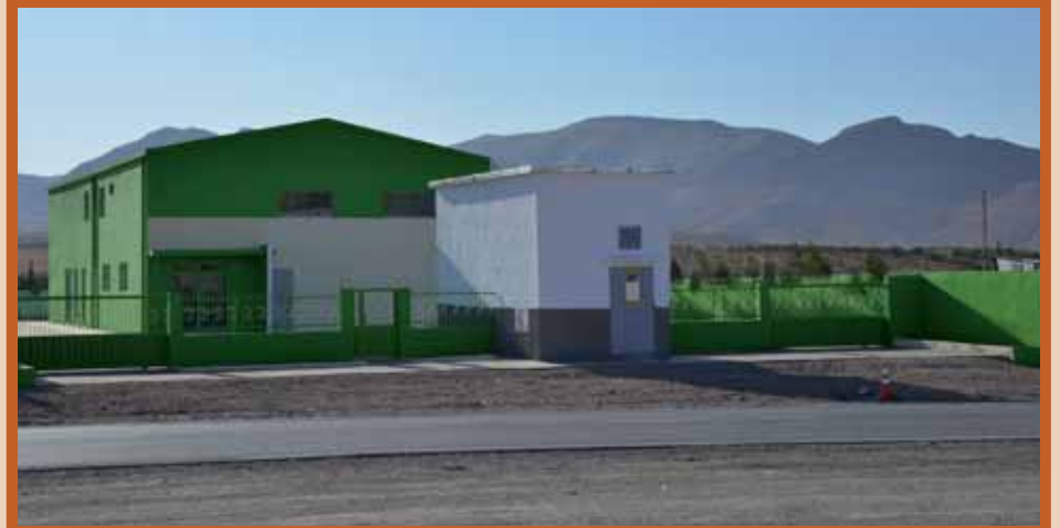
المؤسسات الصناعية الجديدة لجرادة (بما فيها مصنع تقشير وتوضيب الجنبري، أعلاه، ومنشأة تعقيم المخلفات الطبية للجهة، أسفله)، خلقت مناصب شغل استعد لها الشباب، ومن بينهم، بمساعدة منصة الشباب
