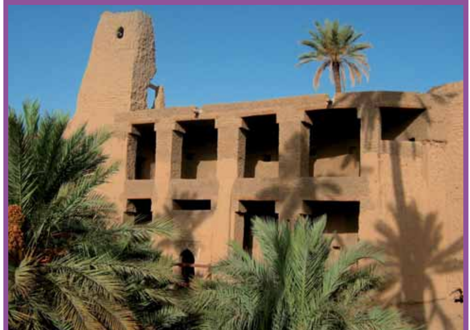
ترميم الرواق المبني بالتراب بساحة أجدير بفجيج
