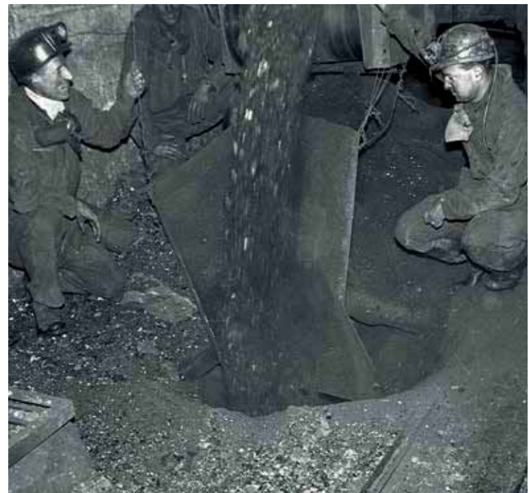
► Evacuation du charbon par un trou hélicoïdal dans le sol, le plus souvent en bout d'un tapis roulant (1958) (archives)
