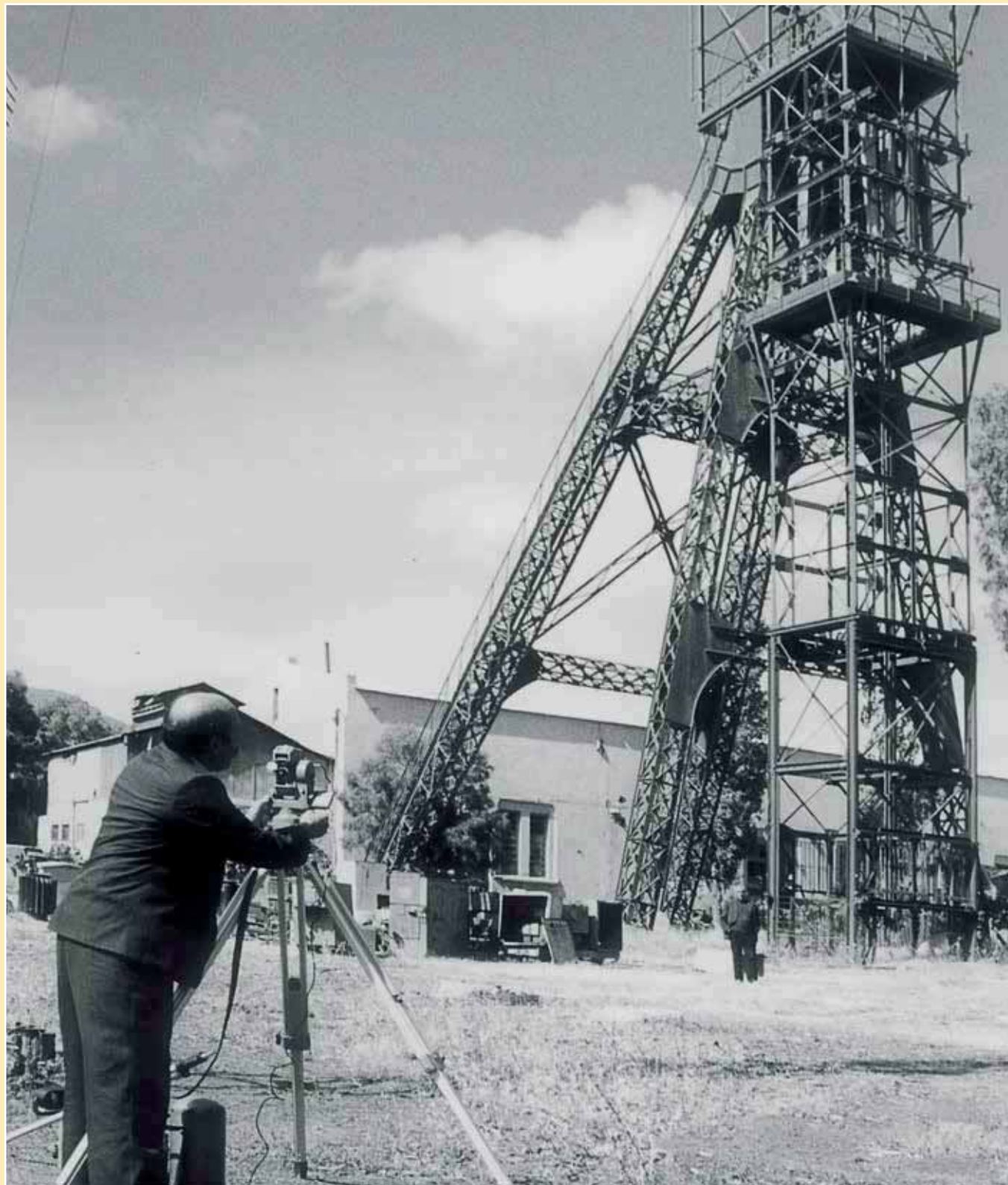
► Le géomètre vérifie l'implantation du premier chevalement (Puits 1, Bassin 150) [archives]
