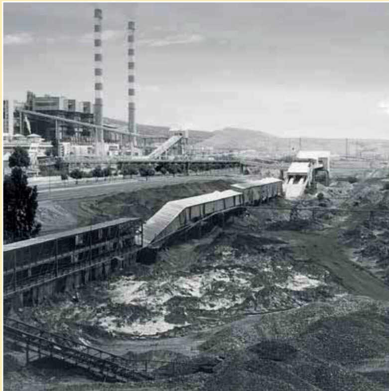
➤ Le stock de fines d'anthracite et le convoyeur de la centrale thermique (archives)
