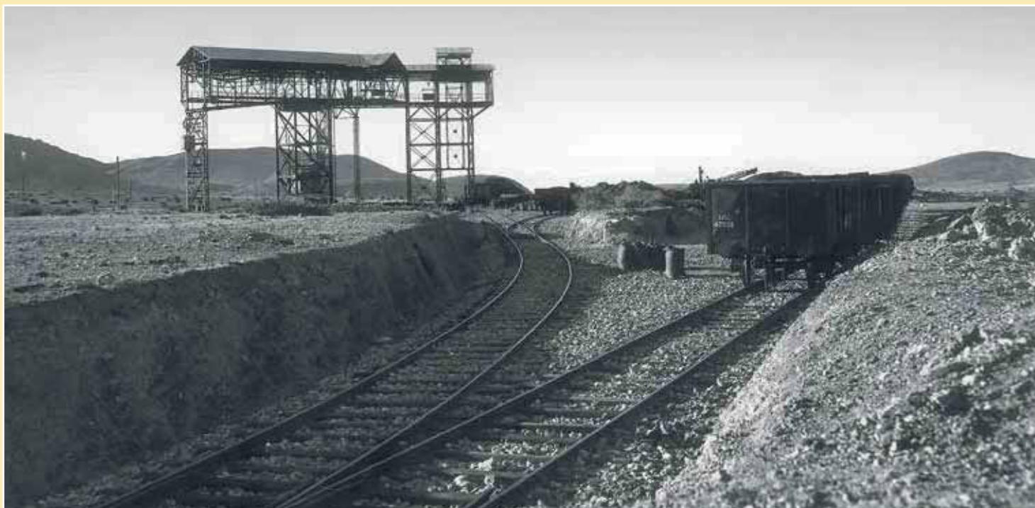
➤ A Guenfouda, la structure de réception des bennes – ou berlines – du téléphérique à partir de laquelle sont chargés les wagons. Entre les deux voies, des sacs d'anthracite de taille calibrée, prêts au départ vers les acheteurs (archives)
