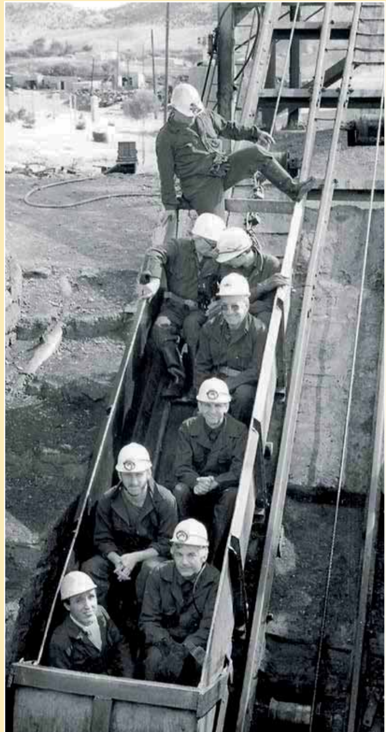
➤ Les "skips" le moyen moderne et rapide pour descendre le personnel et le matériel, ou remonter le charbon extrait (archives)
