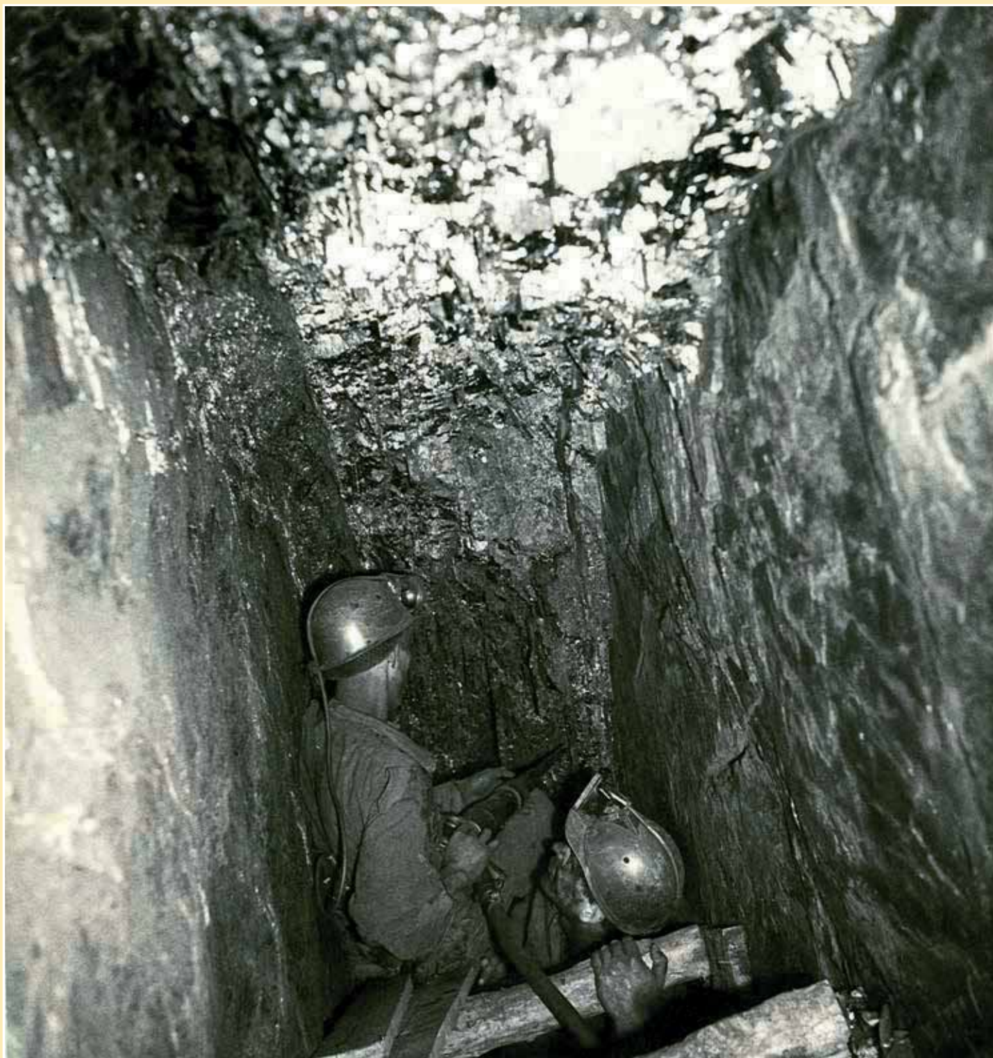
► Le marteau piqueur pneumatique est inventé en 1921 par les frères Armand et François Colinet. Le nom du modèle, «La Croix», est donné en référence à l'ami prêtre qui avait suggéré l'idée. Dès les années 1940, il remplace les outils à main à Jerada (ici en 1959) (archives)
