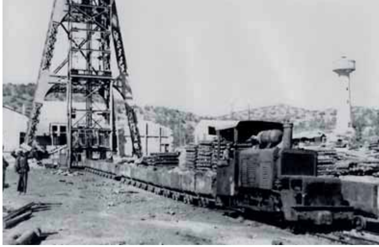
◀ يجلب القطار الصغير الفحم المستخرج من مسار الهبوط إلى عربات السكك الحديدية (أرشيف)
