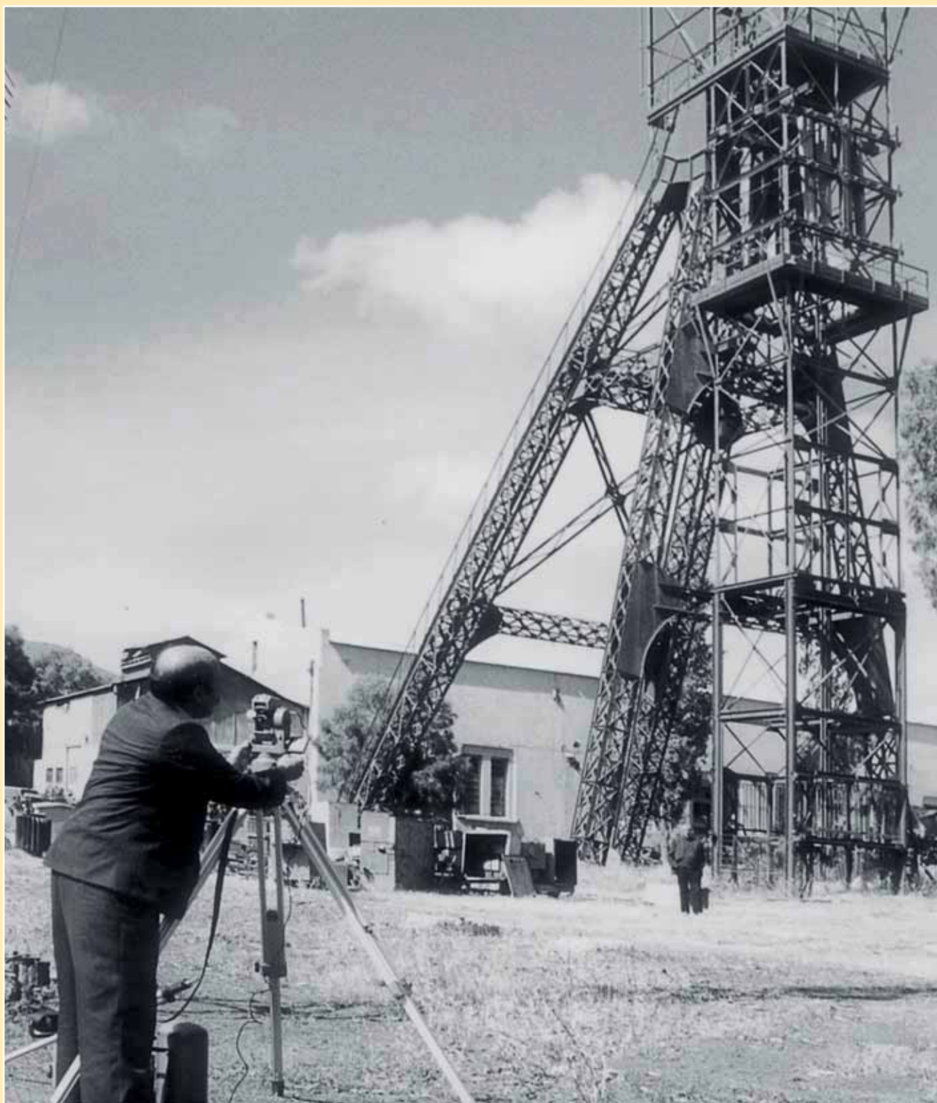
يقوم المساح باختبار السناد الأول "لكاج" (البئر 1، الحوض 150) (أرشيف)
