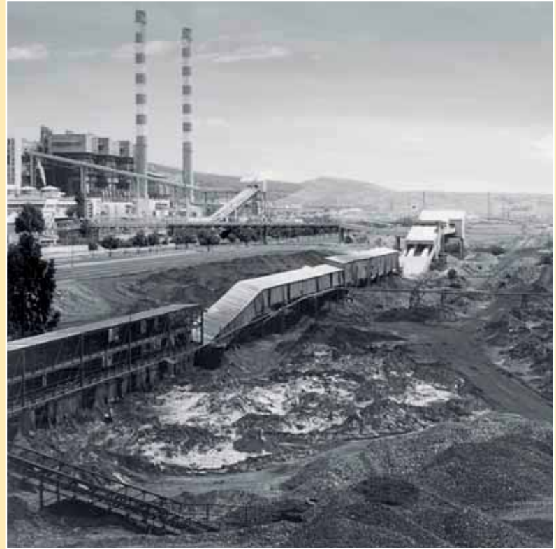
مخزون رقيق الفحم الحجري والناقلة التي تزود مركز توليد الطاقة (أرشيف)
