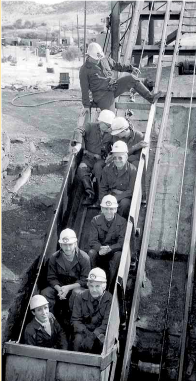
«العربات المتنقلة»، الوسيلة الحديثة والسريعة لهبوط المستخدمين والعتاد، أو لصعود الفحم المستخرج (أرشيف)
