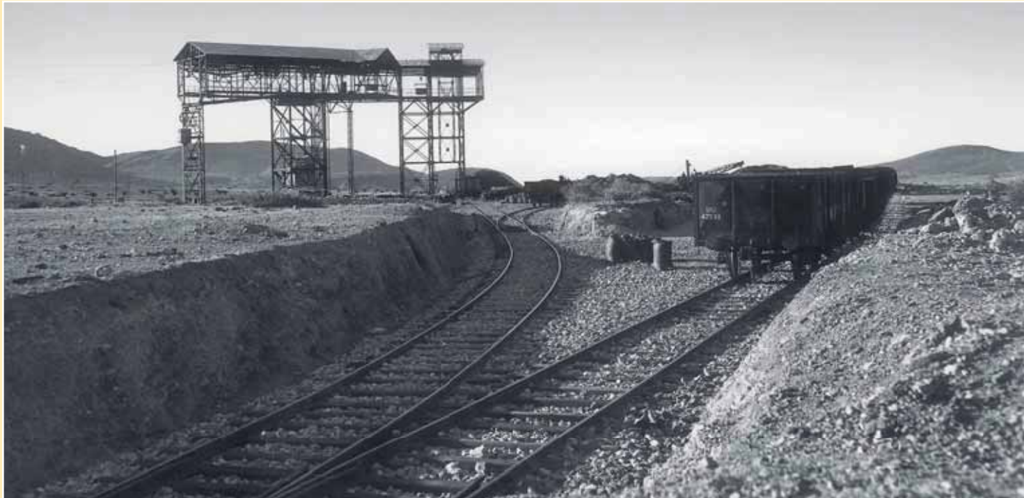
◀ منشأة استقبال مركبات التيليفريك بـكُنفودة حيث يتم شحن القاطرات. بين السكتين أكياس الفحم الحجري من حجم كبير، جاهزة لنقلها للمشتريين (أرشيف)
