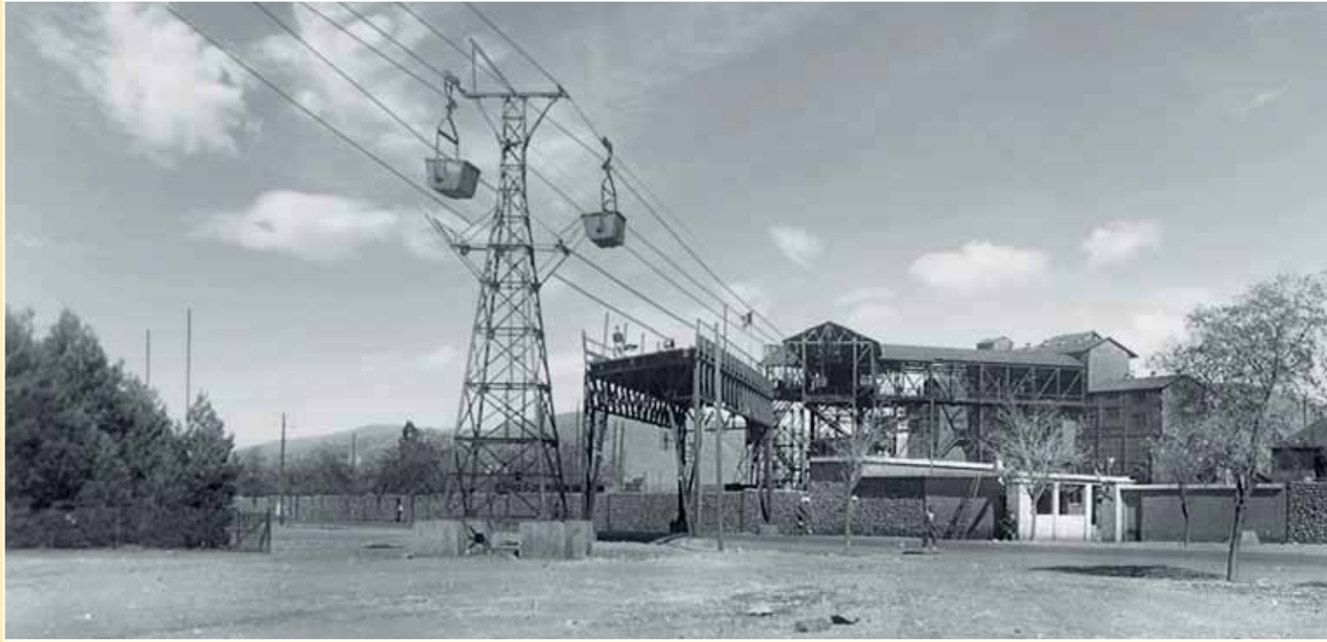
◀ يربط هذا التيليفريك جرادة بمغسل كُنفودة على امتداد 22 كلم (أرشيف)
