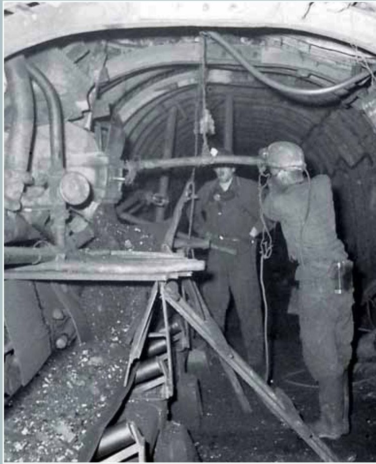
إخراج الفحم من الأنفاق بواسطة بساط متحرك (أرشيف)
