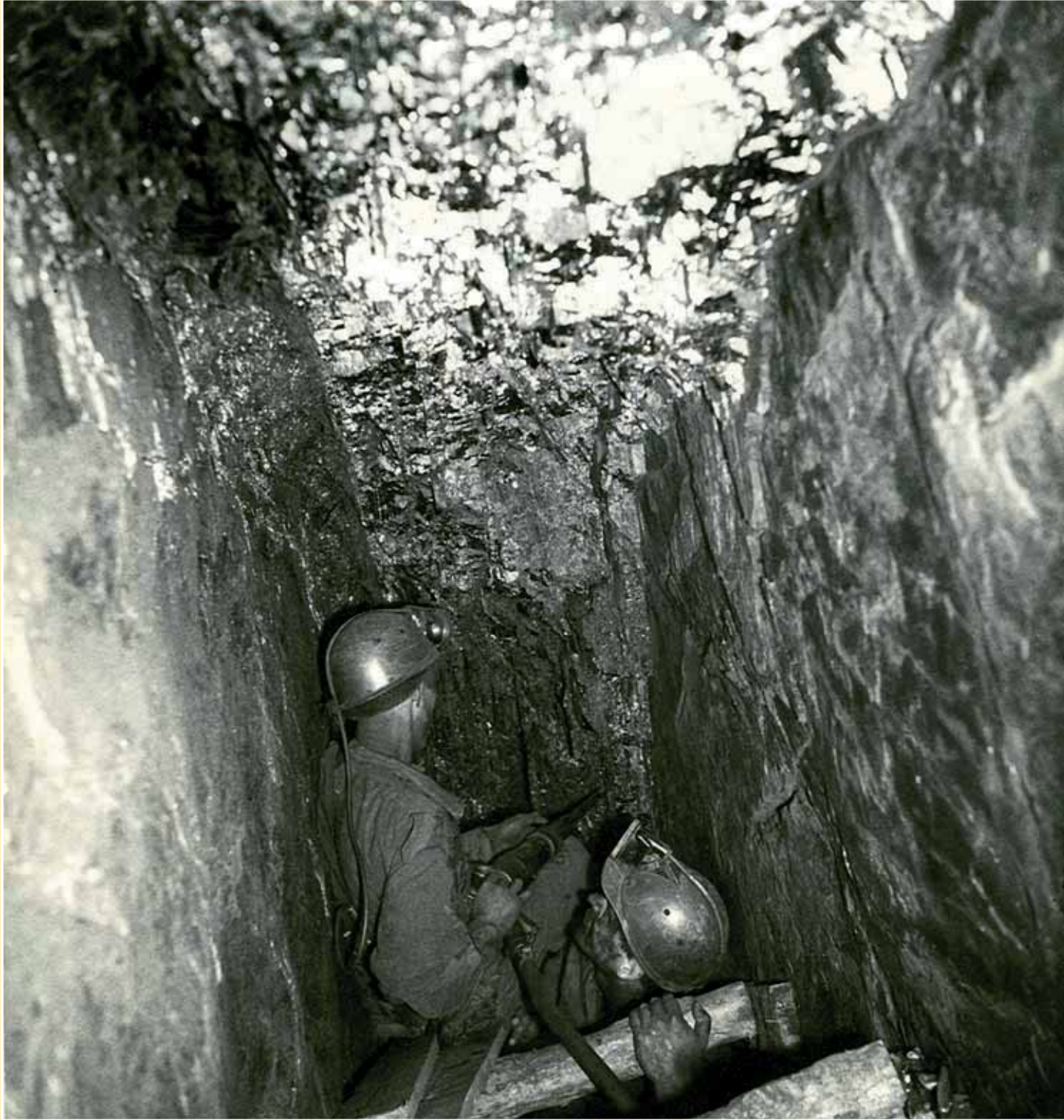
◀ اخترع الأخوان أرموند وفرانسوا كوليني سنة 1921 حفارة بالهواء المضغوط، سميت بـ "لاكروا" نسبة إلى الكاهن الذي اقترح الفكرة. ومنذ الأربعينيات، عوضت هذه الآلة الأدوات اليدوية التي كانت تستخدم بجرادة (الصورة تعود لسنة 1959) (أرشيف)
