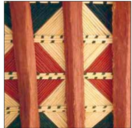
Solaio tipo A Plancher type B (poutres et travi e karnef) baguettes en laurier rose Solaio tipo B (travi e bacchette di oleandro)
