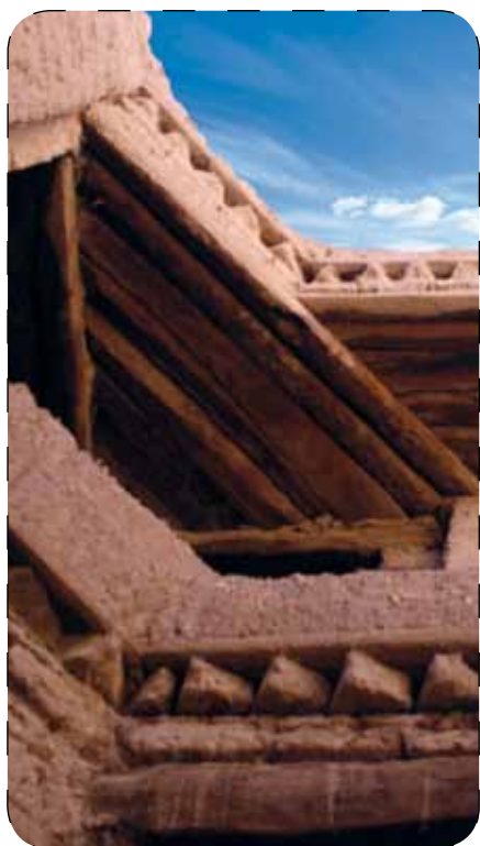
Bâtiment en terre en cours de restauration
