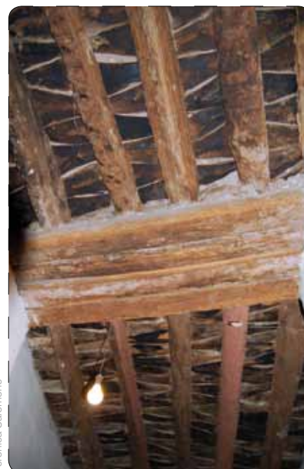
Plancher ancien entretenu et non altéré
