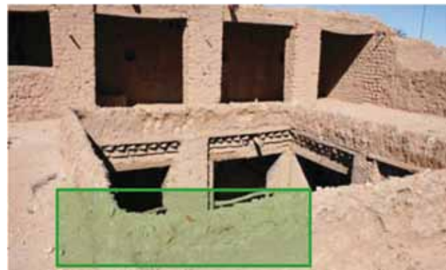
Evoluzione dell'erosione sull'intero sistema edilizio
