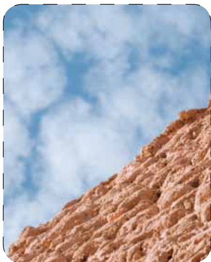
L'ancien tissu construit se dégrade
