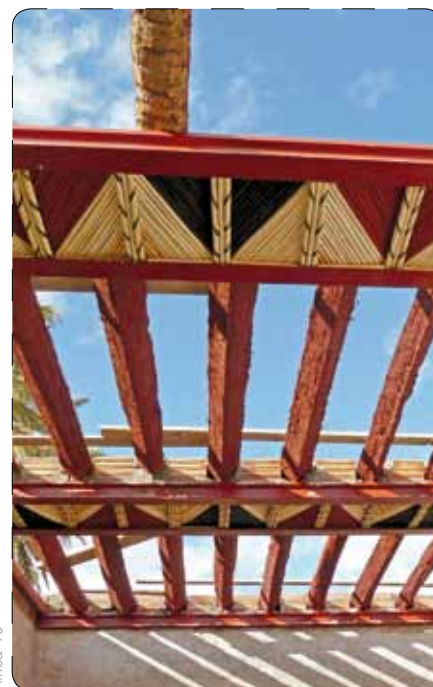
Plancher restauré de façon traditionnelle
