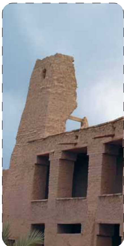
Restauration en cours de la Muraille d'Ajdir
