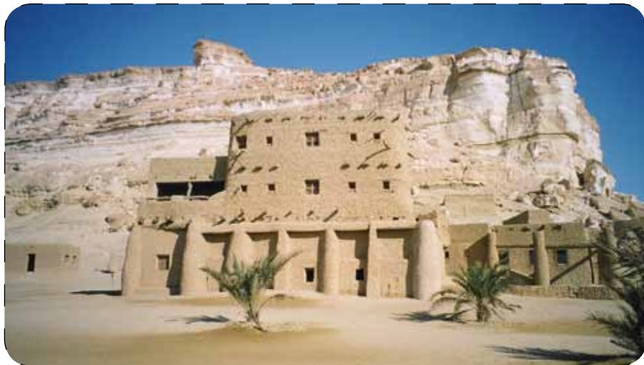
La ville oasis de Siwa (Egypte) en réhabilitation
