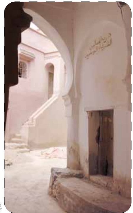
Réhabilitation en cours
