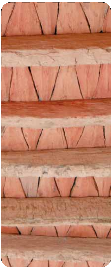
Plancher restauré, poutres et karnafs de palmier
