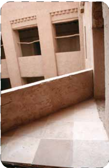
Sauvegarde du patrimoine : maison en restauration
