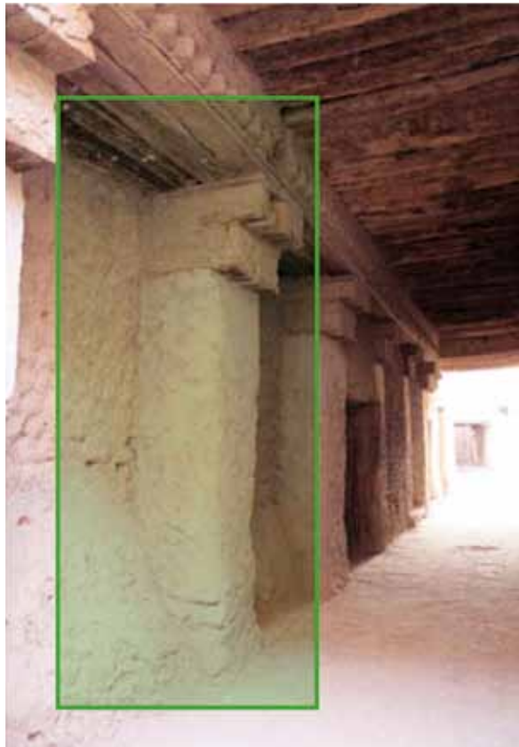
Évolution de l'érosion de tout le système constructif
