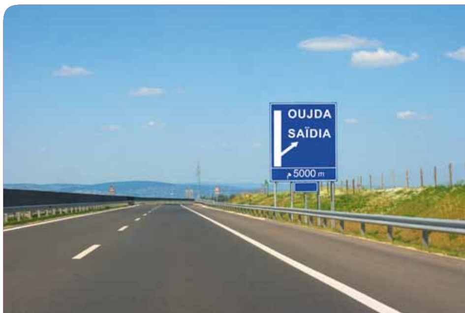
Les infrastructures modernes desservent aussi bien les sites industriels que les hauts lieux touristiques
