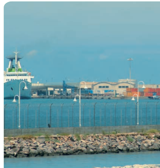
Requalification du port de Nador
