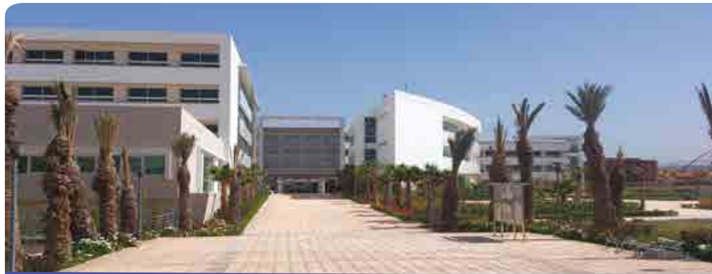
Un monument d'architecture moderne au service de la santé
